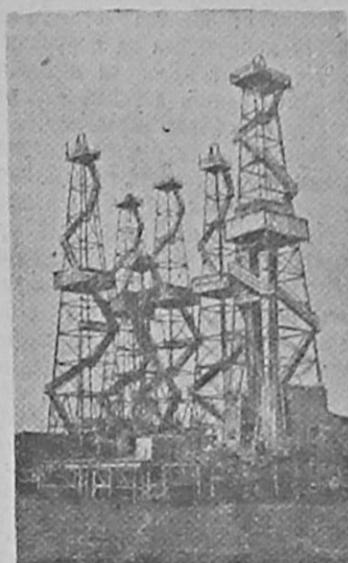
Баку. На морских нефтяных промыслах широко применяется так называемое кустовое бурение. Проходка нескольких нефтяных скважин ведется наклонно-направленным способом с одной площадки. Этот способ позволяет с меньшими затратами осваивать нефтесосные площади, находящиеся на дне Каспийского моря.
